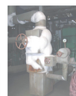
既設配管 -90°C 硬質ウレタン
