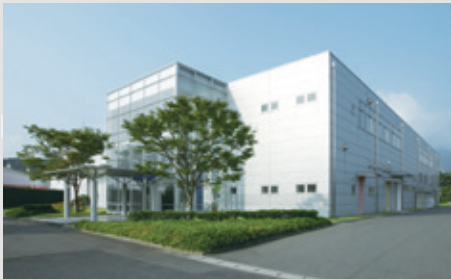
真空機器工場 Vacuum equipment plant
