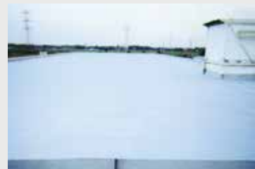
屋上ウレタン防水工事 Roof urethane work
