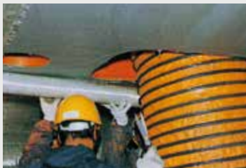
下水道施設FRPライニング FRP linings for sewage treatment facilities
