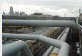
製鉄設備ガスダクト内外面複合ライニング FRPライニング、フレークライニング Anti-corrosion compound linings of exterior/interior surfaces in steel-plant gas ducts FRP linings, flake linings
