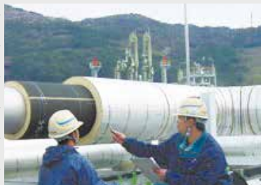
LNG受入配管設備の保冷
