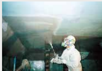
上水道施設(配水池等)の防水、防食ライニング Water-proofing of water-supply facilities (ponds, etc.), anti-corrosion linings
