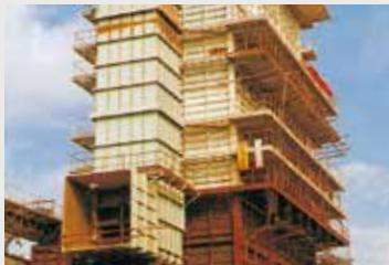
発電プラント 排煙脱硫装置フレークライニング Anti-corrosion protection for power plant smoke-stack desulfurization equipment (flake lining)
