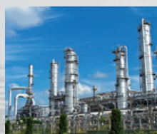
石油化学プラント Petrochemical plant
