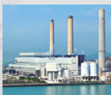
電力工場 Power plant
