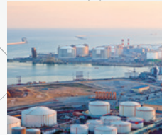
LNG基地 LNG installations
