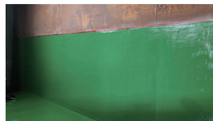
工事完了後の状態
