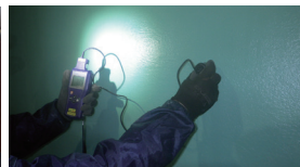
③フレーク樹脂2層目&自主検査
