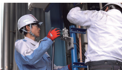
ケーブル敷設
