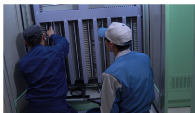
制御機器設置
